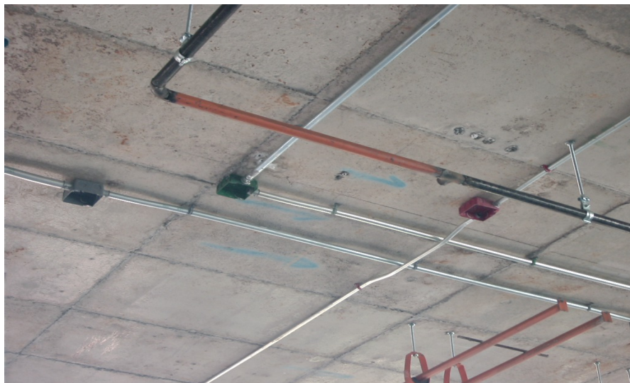
รูปการติดตั้งท่อร้อยสายเข้ากับกล่องต่อสาย
