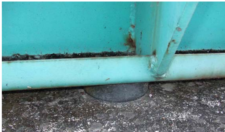
รูปการติดตั้งสปริงลดการสั่นสะเทือน
