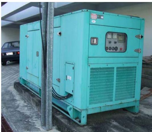
รูปการติดตั้งเครื่องกำเนิดไฟฟ้าพร้อมอุปกรณ์ประกอบ
