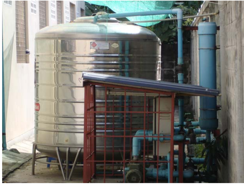
รูปการติดตั้งเครื่องปั้มน้ำที่ใช้กับอาคาร 4 ชั้น
