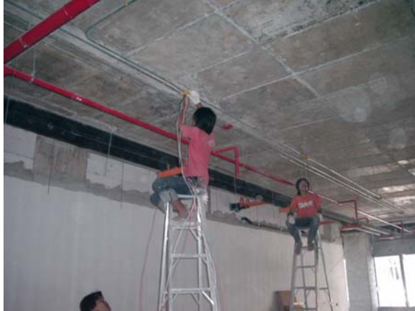
รูปแสดงการปฏิบัติงานติดตั้งไฟฟ้าต้องไม่น้อยกว่า 2 คน
