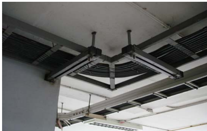
รูปแสดงการติดตั้งรางเคเบิลเพื่อใช้งาน
