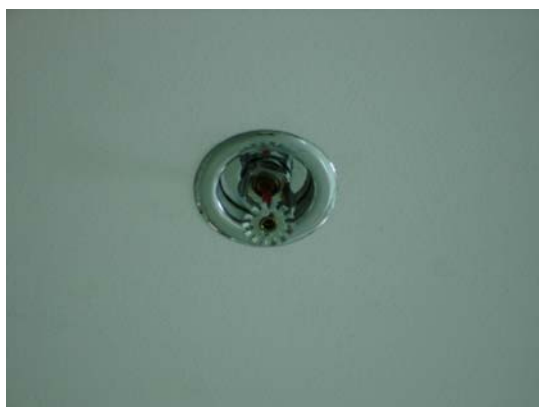
รูปแสดงอุปกรณ์หัว Sprinkler
