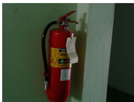
รูปแสดงเครื่องดับเพลิงแบบหิ้ว
