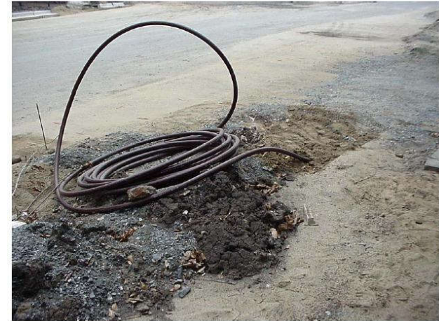
การตรวจสอบระบบไฟฟ้าเบื้องต้น เรียบเรียงโดย อ.มนตรี เจาเดช
