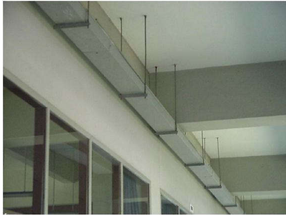
การตรวจสอบระบบไฟฟ้าเบื้องต้น เรียบเรียงโดย อ.มนตรี เจาเดช
