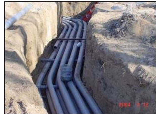
การตรวจสอบระบบไฟฟ้าเบื้องต้น เรียบเรียงโดย อ.มนตรี เจาเดช
