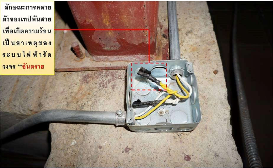
การต่อสายไฟโดยการใช้เทปพันสาย
