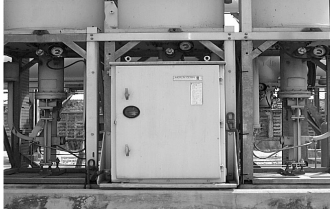
รูปที่ 14 กลไกการขับเคลื่อนเซอร์กิตเบรคเกอร์แบบไฮดรอลิก
