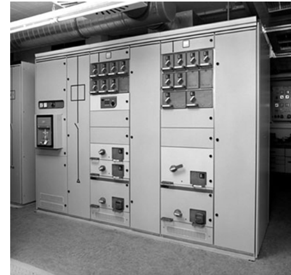
รูปที่ 5.20 ลักษณะภายในและภายนอกของแผงสวิต
