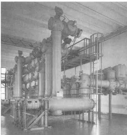
รูป INDOOR SUBSTATION
