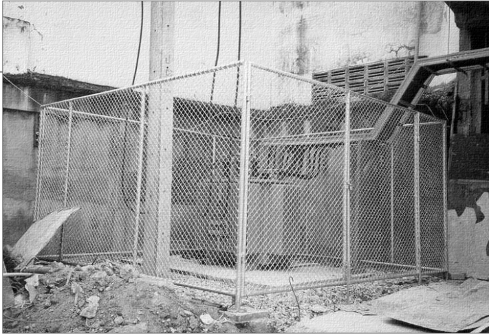
รูปที่ 6.40 การติดตั้งหม้อแปลงไฟฟ้าบนพื้นดิน
