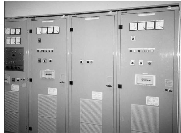
รูปที่ 6.44 ลักษณะแผงควบคุมไฟฟ้าหลัก(ต่อ)
