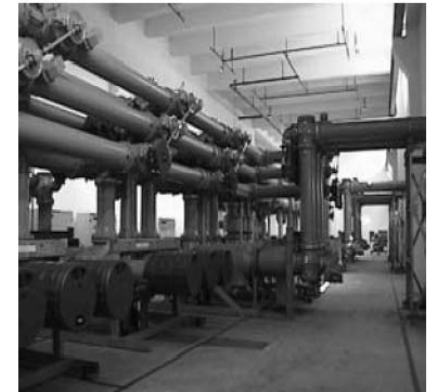
Fig. 2. 275 kV GIS Switchgear Room
